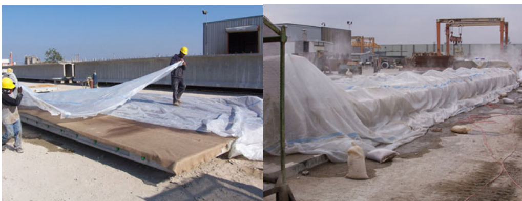
شکل 2: عمل آوری بتن پیش ساخته به روش پوشش سطحی
