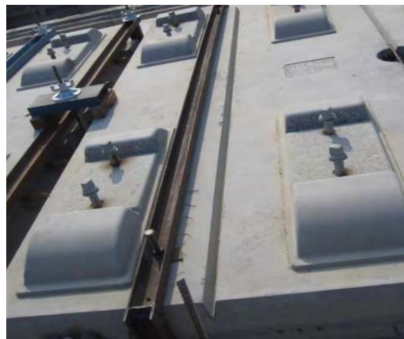
شکل ۷- تجهیزات بسته‌شده برای تنظیم دال در خط CRTS II راه آهن پرسرعت جینگ-هو ۱ [۲۸]
