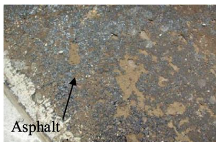
شکل ۵- تشخیص کیفیت نامناسب به علت خیس کردن نامناسب [۲۸]
