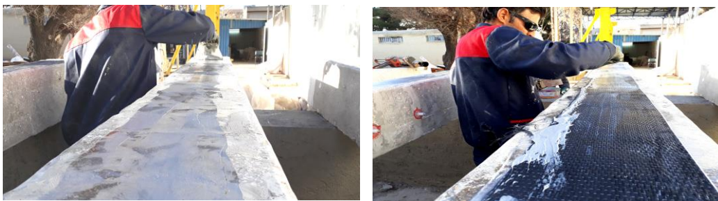
شکل ۹- نصب الیاف FRP
