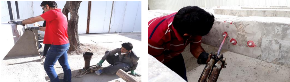
شکل ۸- نصب پستونک ها و تزریق رزین
