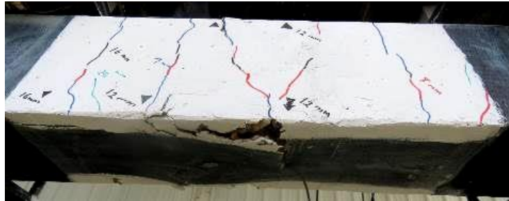
شکل ۲۰- ترک های متناظر و جدانشدگی FRP در نقطه B در نمودار نیرو-جابجایی تیر شماره پنج تحت بارگذاری رفت و برگشتی
