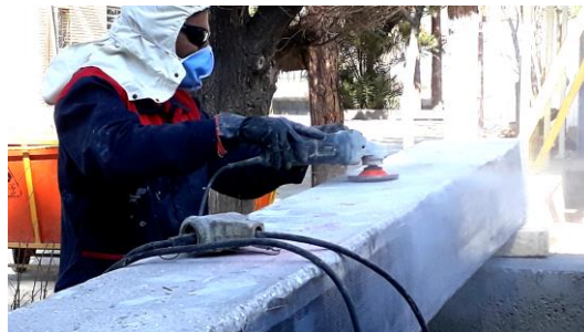
شکل ۶ - انجام ساب و پخ تیرهای بتنی آسیب دیده
