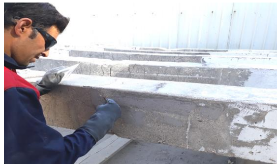
شکل ۷ - بتونه کشی بر روی ترک ها
