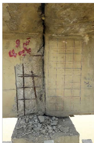
تصویر (۱۰) - تعیین میلگردهای تیر در تکیه گاه از طریق سونداژ (تکیه گاه)
