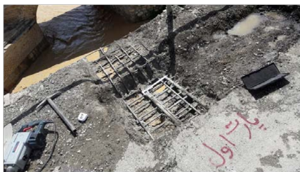
تصویر (۸) - شبکه میلگرد دال عرشه در دهانه اول پس از انجام عملیات سونداژ
