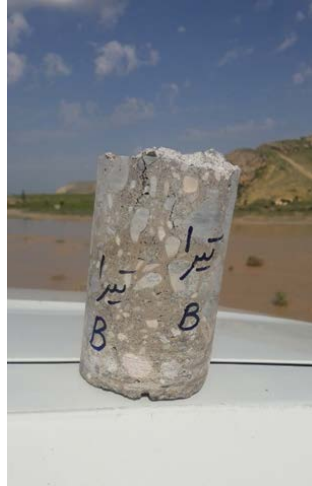
تصویر (۱۴) - ترک در عمق نمونه اخذ شده از یکی از تیرها
