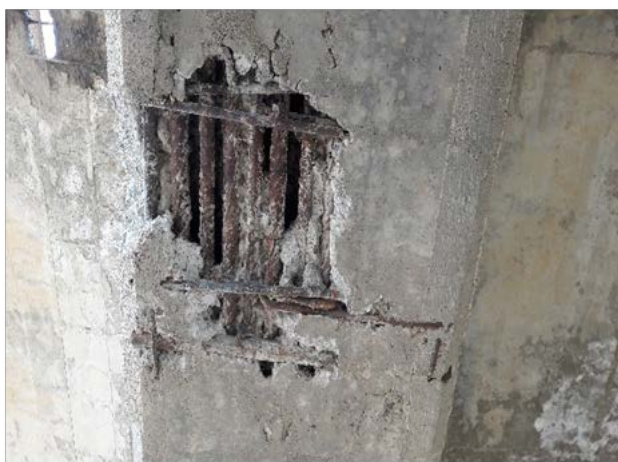
تصویر ۴- نمای تحتانی یکی از تیرهای عرشه- زوال بتن و خوردگی میلگردهای اصلی تیر
