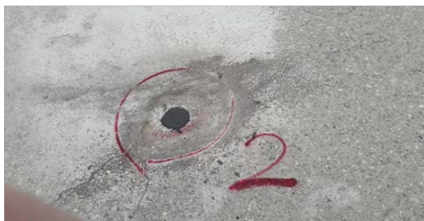
تصویر (۱۳) - ترمیم محل مغزه گیری با گروت سه جزئی
