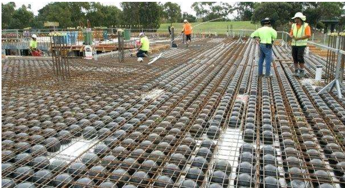
شکل ۱: اجرای دال بتنی مجوف حباب دار با گویهای کروی پلاستیکی
