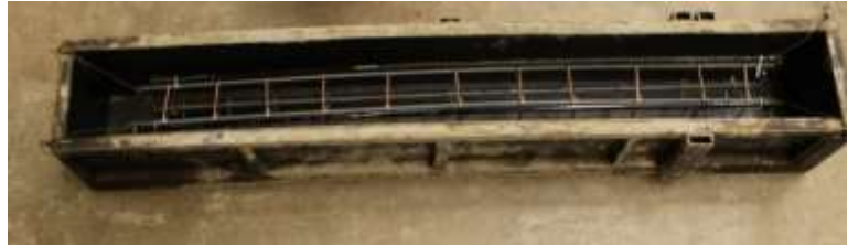
شکل ۴- اتصال کپسول های ۱ متری محتوی کموزیل به شبکه آرماتور
