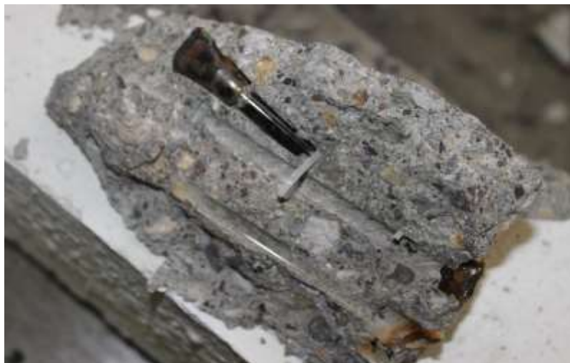
شکل ۱۳. عبور ترک از روی انتهای لوله ۱۰ سانتی متری و عدم شکست لوله در یک ناحیه پس از بارگذاری ثانویه
